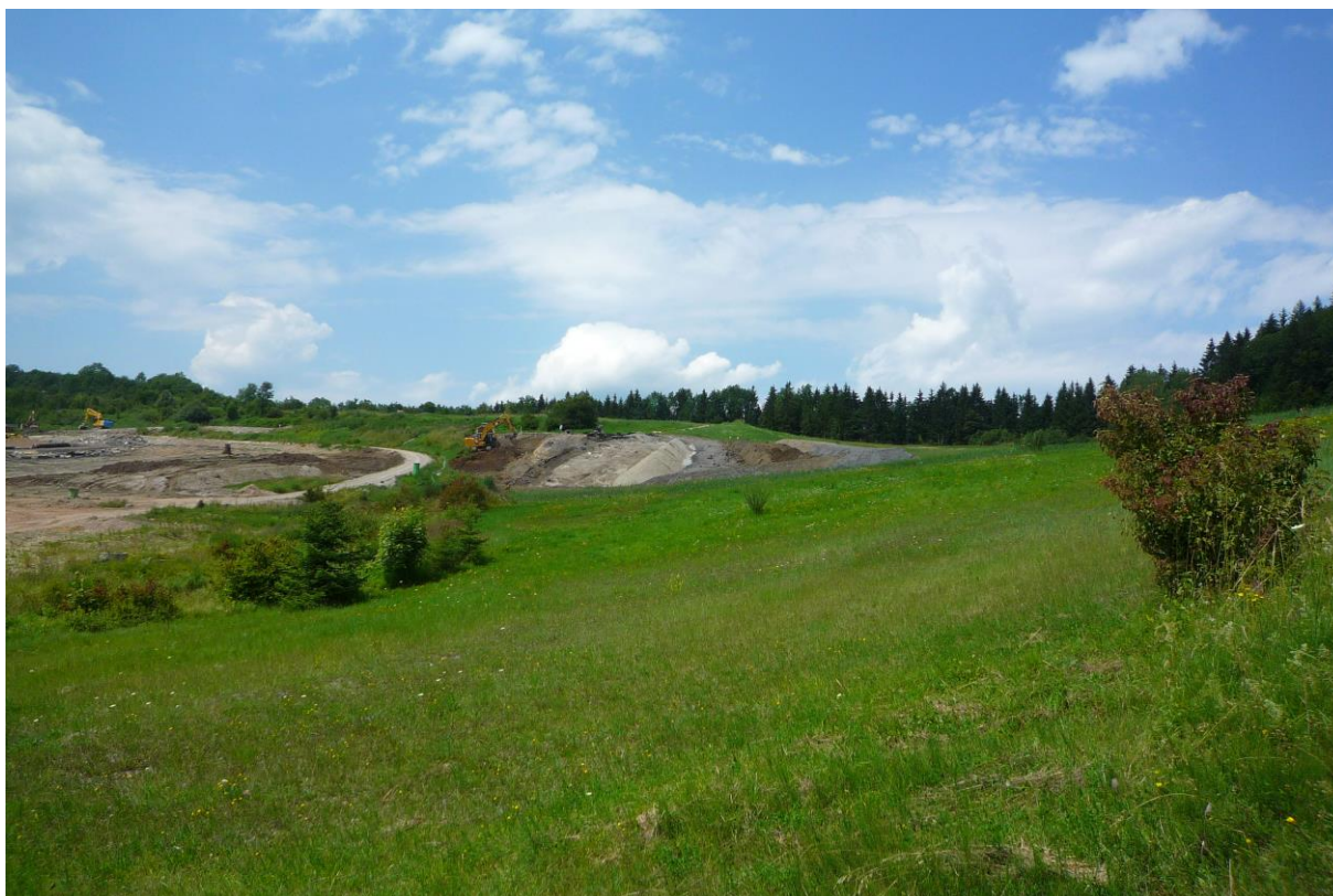
Deponieabdichtung in Hausham (Foto vom 21.07.2020, R.Engelschall)
