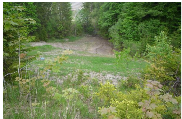
Foto 10: D.2 Absetzbecken Einleitung von Straßengerinne. (20.05.2020)
