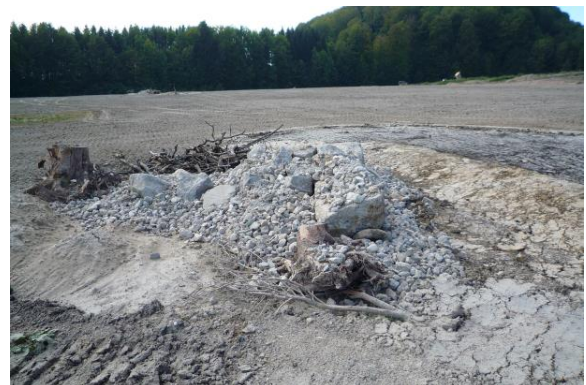
Foto 8: C.1+2 fertig mit Steinhaufen abgedichtet und mit Lehm-Humus aufgeschüttet, mit neu angelegtem Steinhaufen für Zauneidechse. (22.09.2020)
