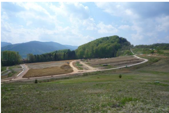
Foto 7: C.123 abgedichtete Flächen links die bereits fertig gestellte Fläche C.1+2, rechts C.3 in Arbeit (25.04.2020)
