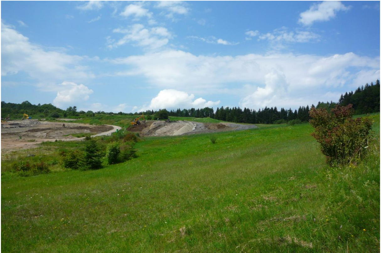
Deponieabdichtung in Hausham: die Arbeiten auf der Fläche C (links) sind in vollem Gange, in der Mitte sieht man den Rutschhang bei der alten Gasstation, rechts im Vordergrund der Hang von Fläche B. (Foto vom 21.07.2020, R.Engelschall)
